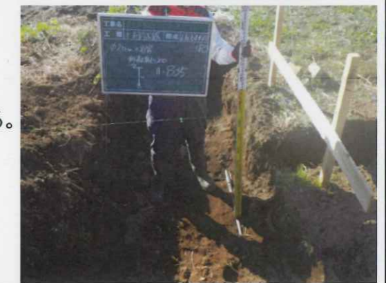
【試掘による確認】
