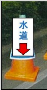
写真1 従前の埋設物の見える化方法
