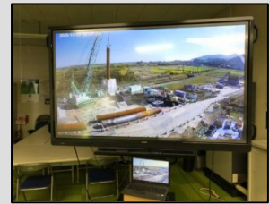
写真3 事務所大型モニター
