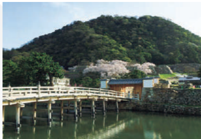
所在地/鳥取県 竣工日/2019年3月29日
