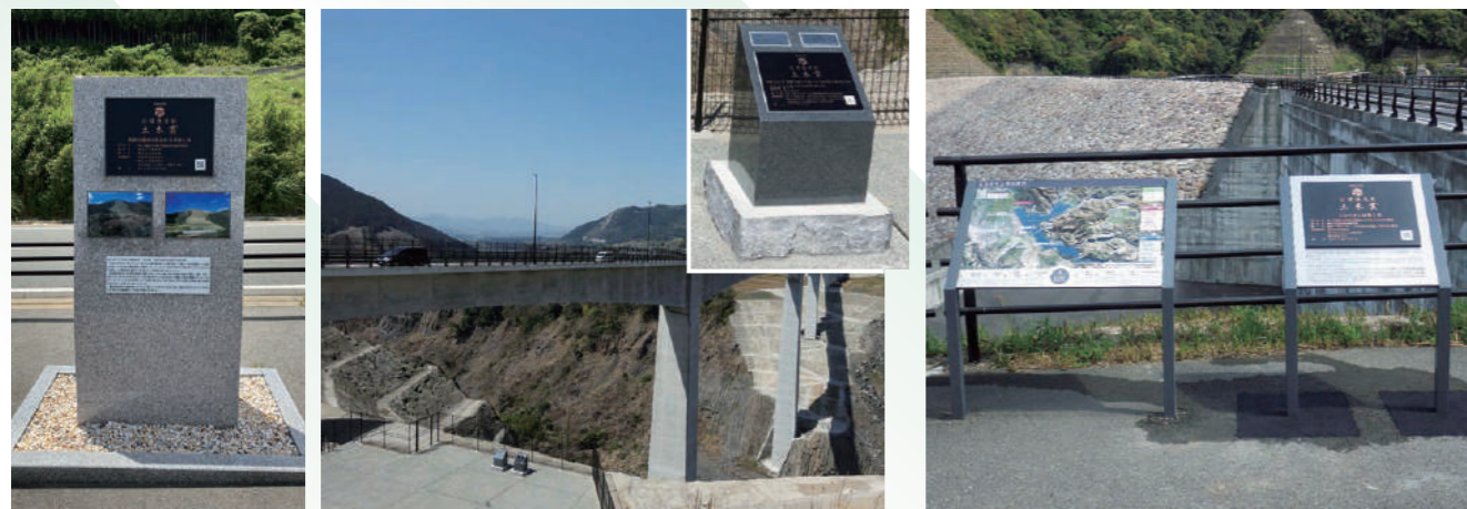
阿蘇大橋地区斜面防災対策工事 (第1回土木賞受賞)
