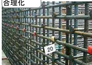
清水建設・Tヘッド工法鉄筋
