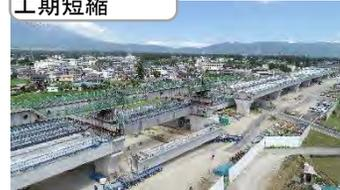
三井住友建設・U桁リフティング架設工法
